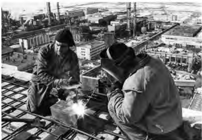
В момент запуска цеха очистки промышленных стоков пусконаладочные работы шли на территории всего завода
